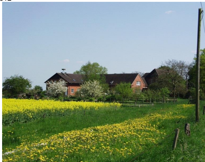
Hof Meyerwiede – Rückansicht
